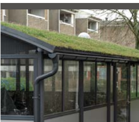
Buet tak med sedum
